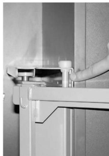
Posizionare la struttura A a filo con il bordo mobile
