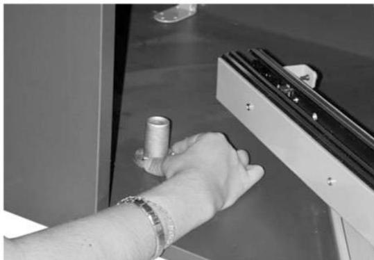
Posizionare il fine corsa P (la sua posizione determina +/- l'apertura della porta)
